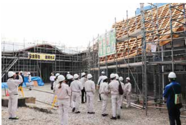
工事現場の見学 Visit a construction site
