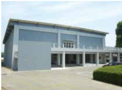
第一体育館 Gymnasium 1
