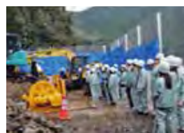
国道219号災害復旧現場の見学
