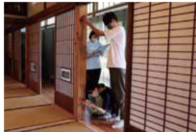
柱の傾きの調査
