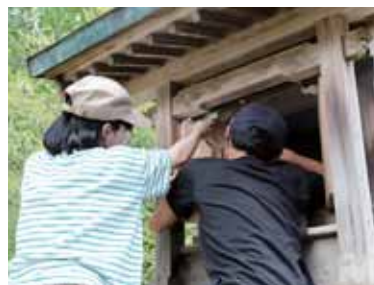
山の神の扉の取付け
