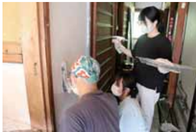
漆喰を塗る修繕作業
