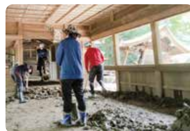
被災地での復旧・調査・修復作業
