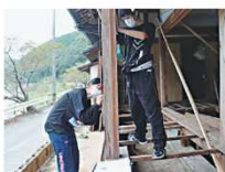
学生による被災状況調査
