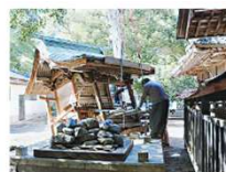
ボランティア団体との復旧作業
