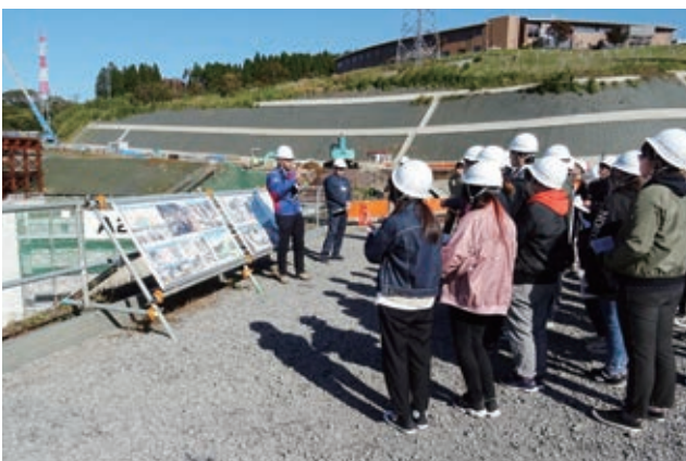
工事現場の見学 Visit a construction site
