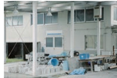
建設技術材料試験所 Construction Material Engineering Laboratory
