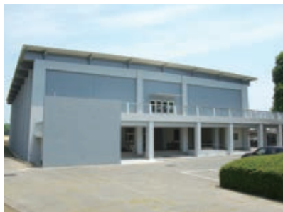
第一体育館 Gymnasium 1
