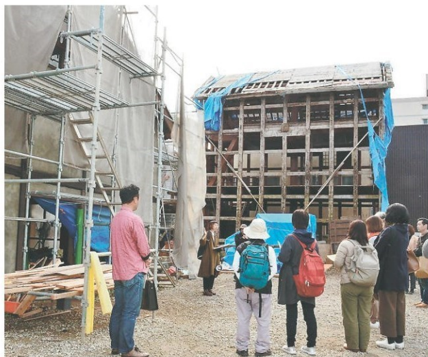
熊本地震で被災した町家の修理状況を見学する建築士ら参加者
