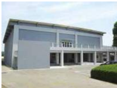
第一体育館 Gymnasium 1
