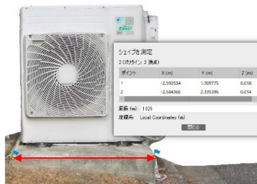
図18 室外機のコンクリート土台の横幅
