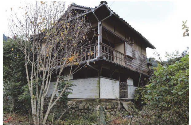
図11 釜屋外観（令和2年11月20日撮影）
