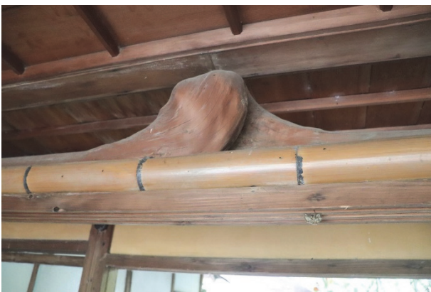
図 13 竹の長押しと変木の欄間 (令和 2 年 8 月 29 日撮影)
