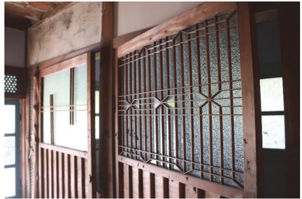
図 15 離れの便所入口 (令和 2 年 8 月 29 日撮影)
