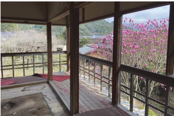
図10 二階の縁廊下 （令和2年3月8日撮影（提供：奥羽未来））
