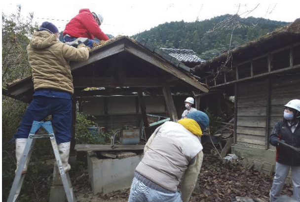
図 17 井戸の解体作業 (令和 2 年 12 月 19 日撮影)
