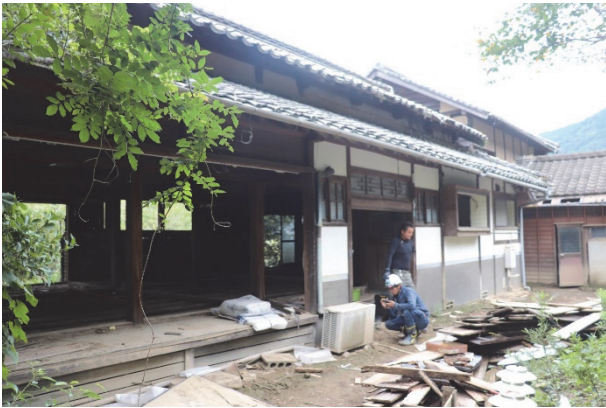
図5 母屋の南側、奥に釜屋・シノゴヤ (令和2年8月29日撮影)
