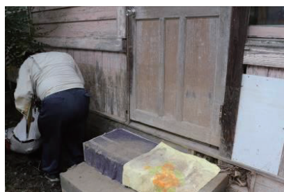
図 23 JA やつしろ坂本支所の 外壁の浸水痕
