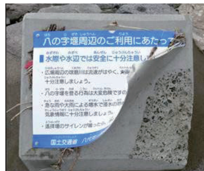
図14 看板の被害状況
