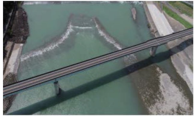
図15 豪雨後の八の字堰
