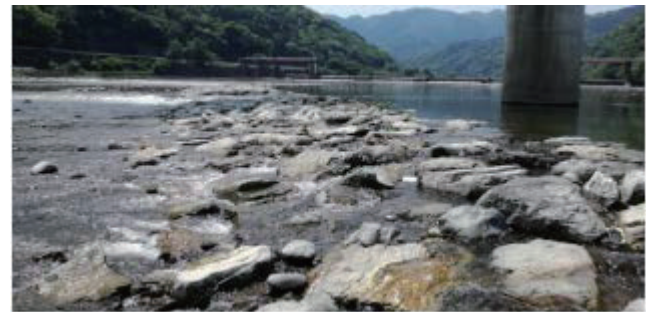
図16 八の字堰の石組み構造
