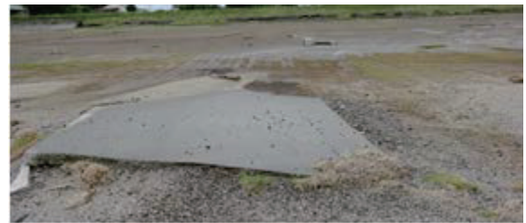
図12 駐車場の被害状況
