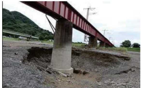
図13 橋脚周辺の被害状況
