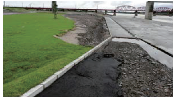
図11 管理用道路および芝生の被害状況
