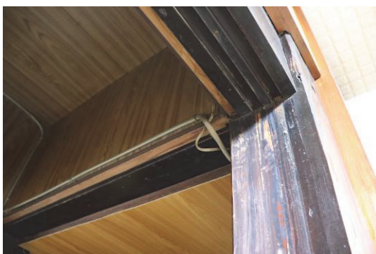
図 30 階段と「どま」の境の無目鴨居（奥） 階段と板間の境の差鴨居（手前） （以上、平成 31 年 1 月 30 日撮影）
