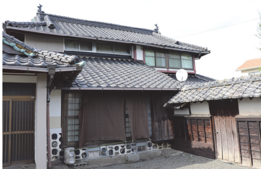
図32 清松家住宅の角屋の外観 (平成30年7月11日撮影)
