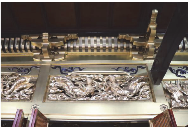
図 16 内陣境 (平成 30 年 10 月 24 日撮影)
