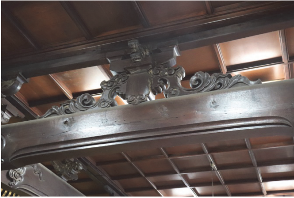
図 15 外陣中央間と脇間の境の大瓶束笏型 (平成 30 年 10 月 24 日撮影)
