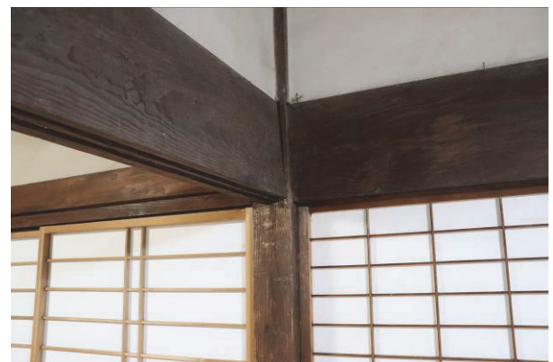
図 30 「中ノ間」の長押（奥）と 「応接間」（手前）の差鴨居 （以上、平成 30 年 12 月 7 日撮影）
