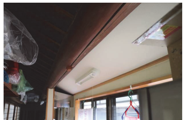
図35 キッチンに残る縁桁（平成30年12月7日撮影）
