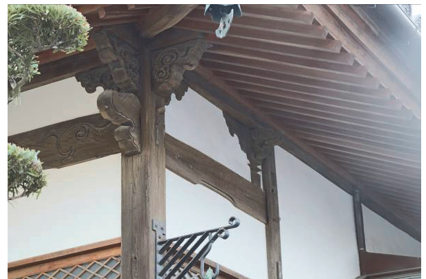
図 19 旧広縁の側面の虹梁 (平成 30 年 12 月 5 日撮影)
