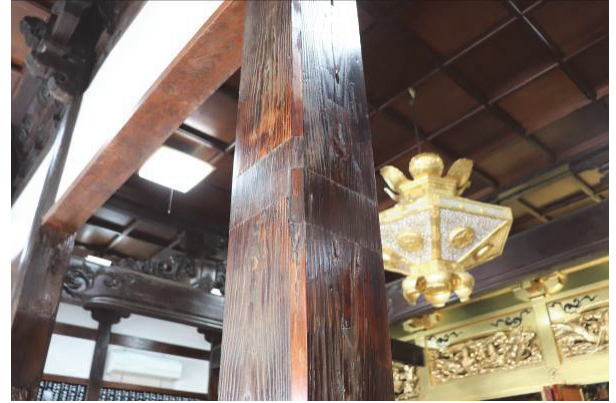
図 18 鴨居と内法長押の痕跡 (平成 30 年 10 月 24 日撮影)
