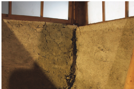
図 18 地階コンクリート壁のクラック (平成 29 年 12 月 14 日撮影)
