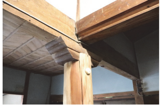
図12 玄関ホール丸柱柱頭（平成30年7月5日撮影）
