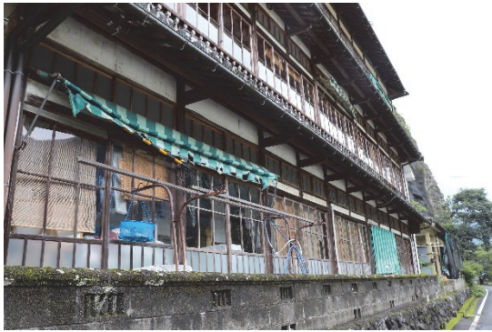
図 7 西側外観（平成 30 年 7 月 5 日撮影）
