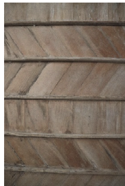
図11 玄関天井 （平成30年7月5日撮影）
