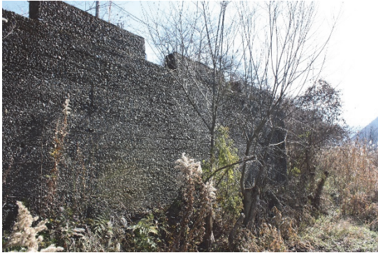
図3 土山茂商店の基礎の遺構（平成30年1月15日撮影）
