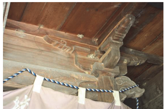
図 15 北片宮内陣の組物周り（平成 28 年 9 月 23 日撮影）
