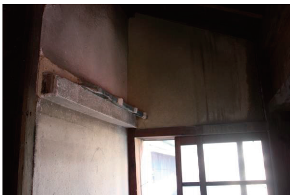
図 2 1 縁廊下の水切り瓦（平成 28 年 12 月 6 日撮影）
