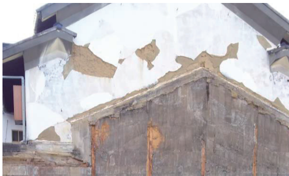
図 1.2 K 邸解体後の S 邸外壁（平成 28 年 10 月 24 日撮影）
