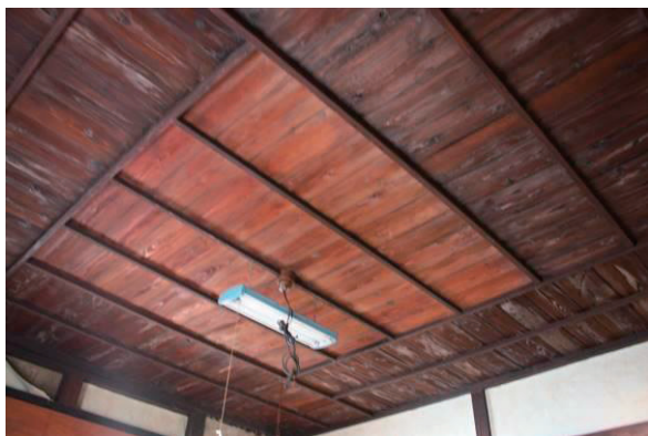
図 2 3 二階座敷天井（平成 28 年 12 月 6 日撮影）
