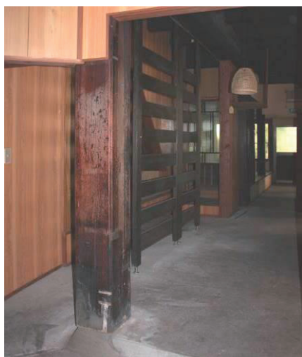
図 2 2 300mm 角の柱（平成 28 年 12 月 6 日撮影）
