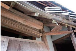
図15 縁桁の破壊
