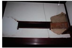
図 29 土壁の剥落
