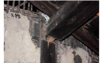
図10 仕口が外れた桁
