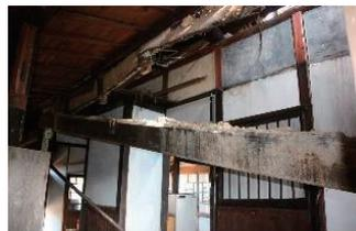
図16 桁行梁の落下
