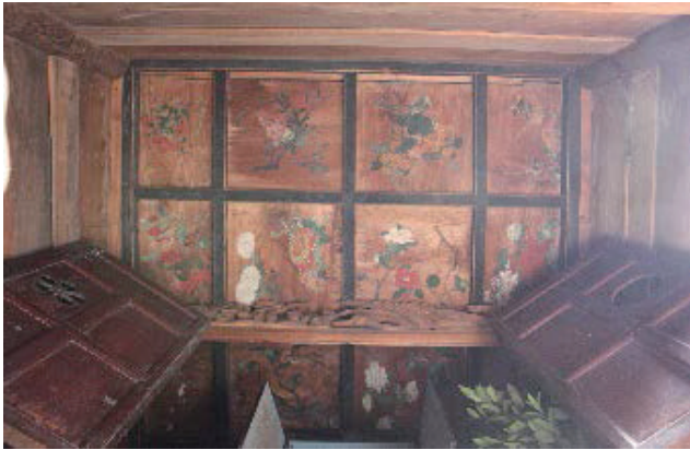
図 13 本殿の格天井（平成 27 年 12 月 27 日撮影）
