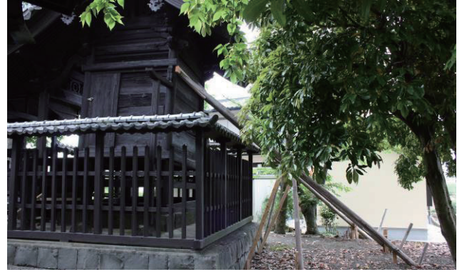
図 30 震災後の本殿の傾斜（平成 28 年 5 月 7 日撮影）
