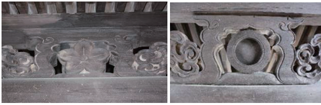
図 12 本殿向拝虹梁の墓股（左：正面、右：背面） （以上、平成 27 年 12 月 27 日撮影）
