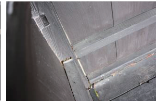
図 32 拝殿腰壁の貫の外れ
