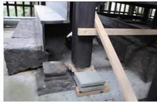
図 31 本殿向拝柱のずれ
