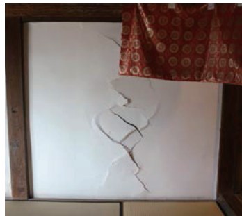
図 33 阿弥陀堂内壁のクラック
