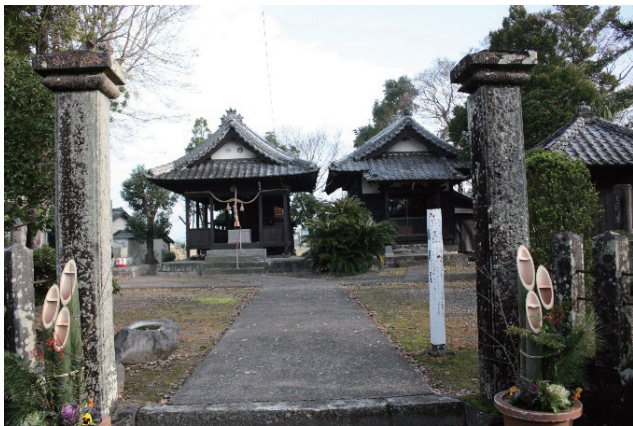
図4 境内全景 (平成27年12月27日撮影)
