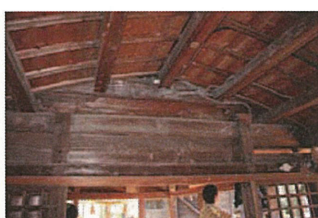
図13 ほぞ穴のある柱筋 (平成 26 年 10 月 30 日撮影)
