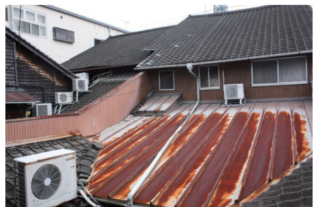
図22 Y邸と西側隣家の屋根（平成26年10月10日撮影）
