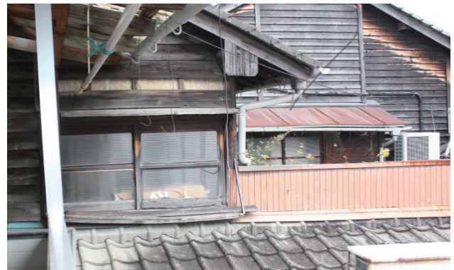
図21 奥棟2階ベランダより東側隣家の窓を見る（平成26年10月10日撮影）
