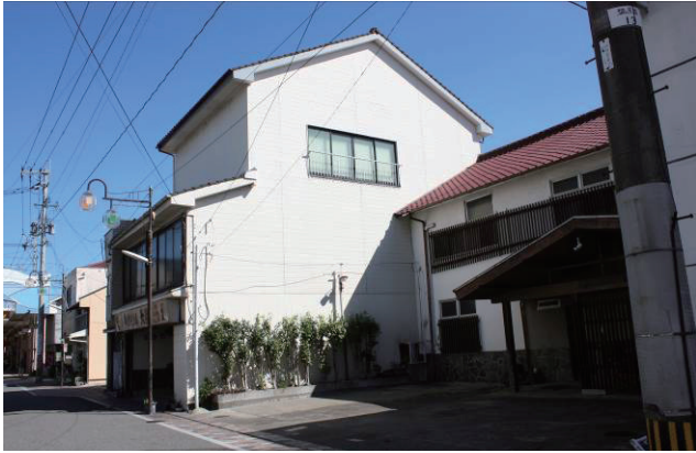
図10 3階建の町家（平成25年9月26日撮影）
