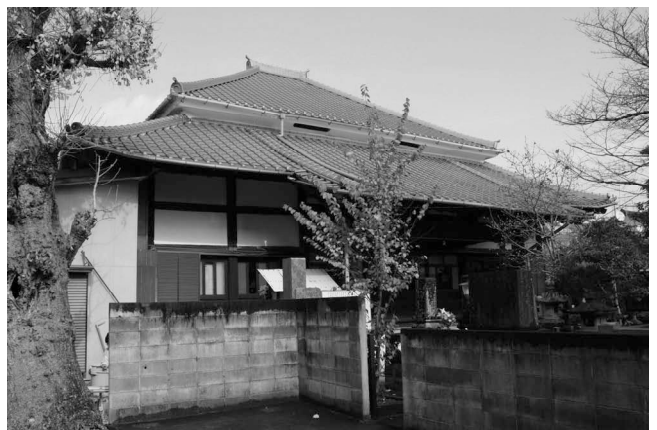
写真1 南西からの外観(平成25年12月11日撮影)
