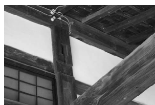
写真2 海老虹梁の痕跡 (平成25年9月10日撮影)
