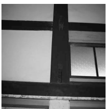
写真7 位牌間の貫の痕跡 (平成25年9月10日撮影)
