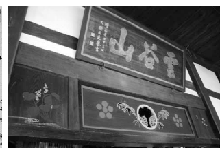
写真4 入側縁の欄間 (平成25年9月10日撮影)
