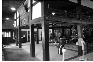
写真5 外陣中央間の長押 (平成25年9月10日撮影)
