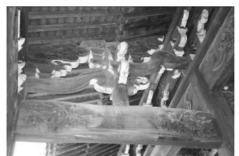
図4 向拝の繫虹梁上部（平成23年9月5日撮影）
