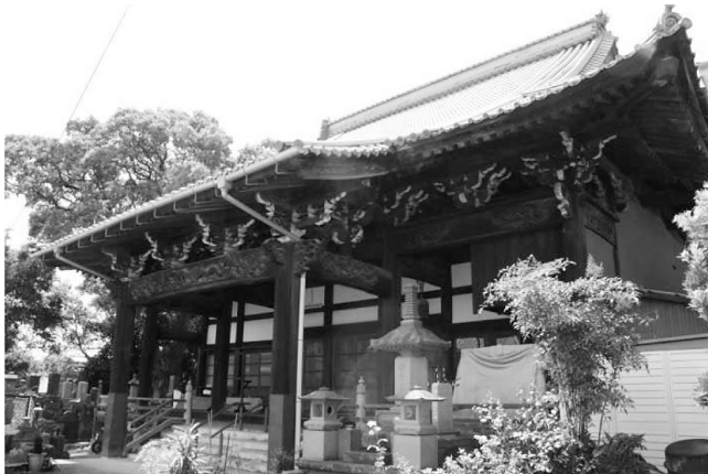
図1 安養寺本堂（平成23年9月5日撮影）
