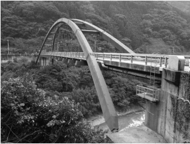
図1 椿橋 (Fig1 Tsubaki Bridge)
