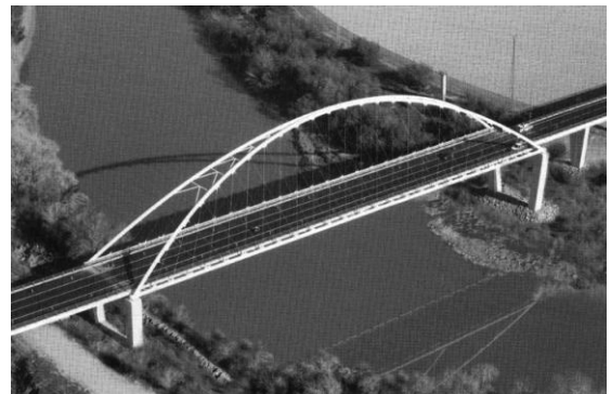
図 9 パルマ・デル・リオ橋 (スペイン) (10),(11) (Fig 9 Palma del Rio Bridge (Spain))
