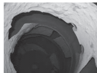
写真7 ドラム内の状況
