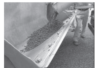
写真6 混練後の状態
