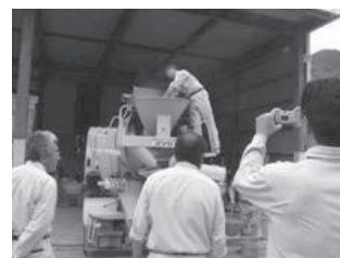
写真5 PSA投入状況
