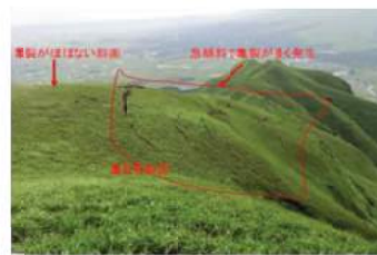
写真2 熊本地震後に生じた地割れ（H28年5月撮影、南阿蘇村）
