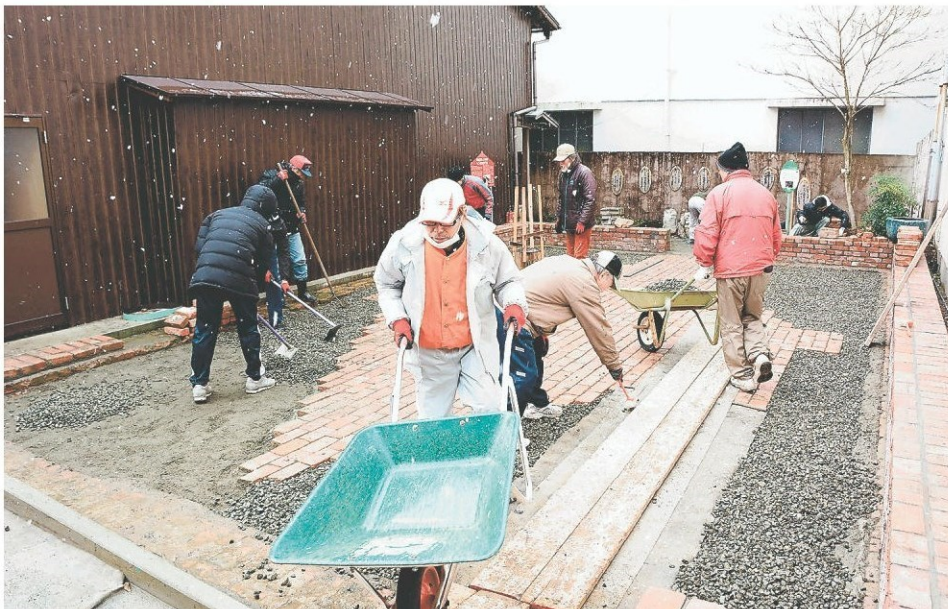
再利用したれんがの敷石の周りに、砂利入れなどの作業をする地元住民ら＝八代市
