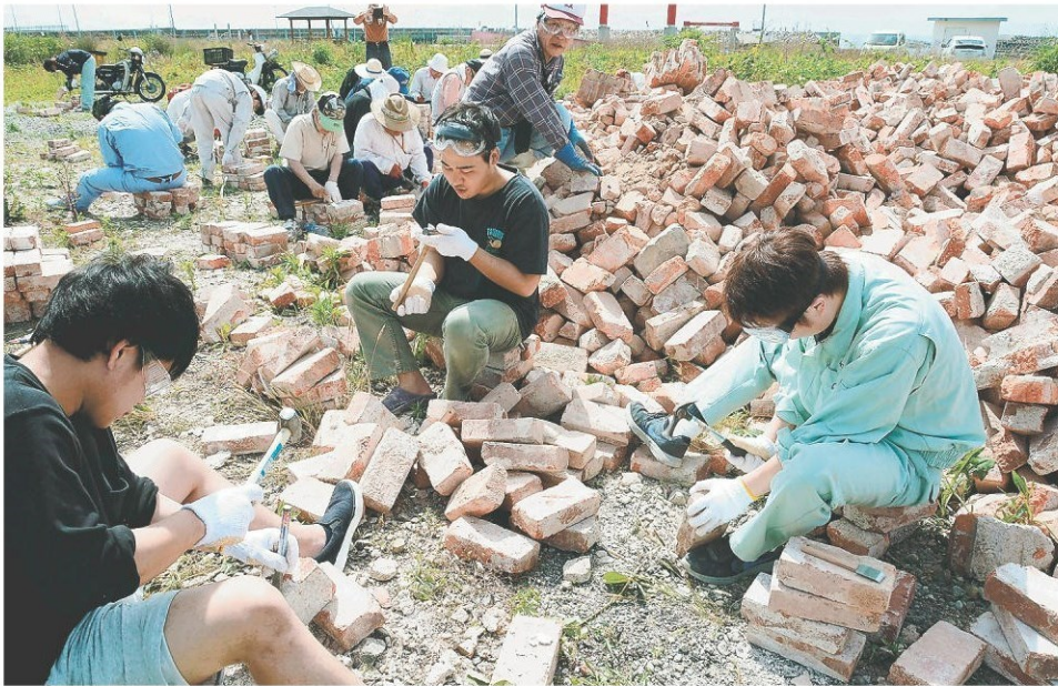
解体したれんがを再利用するため、モルタルなどを丁寧に はがす熊本高専の学生や日奈久地区の住民ら。八代市
