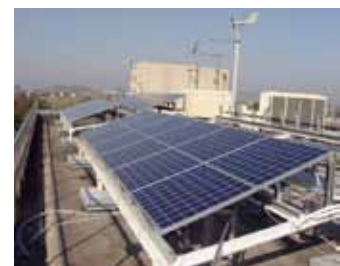
図1 太陽光パネル
