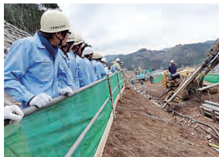
現場見学会(南九州西回り自動車道)
