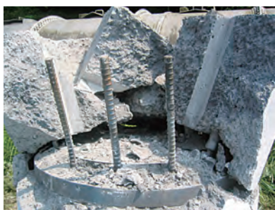
写真1: 縦破断方式の動的破砕処理技術
