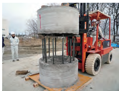
写真4: 杭頭処理部の切り離し
