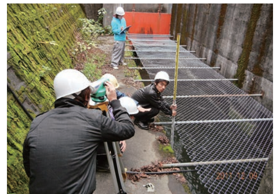
写真-2: 設置想定箇所の調査
