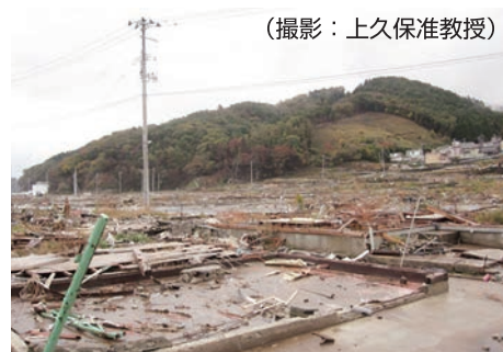
写真1：被災地(宮城県女川町) 〈平成23年11月撮影〉
