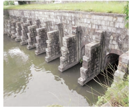
大鞘樋門(八代市)
