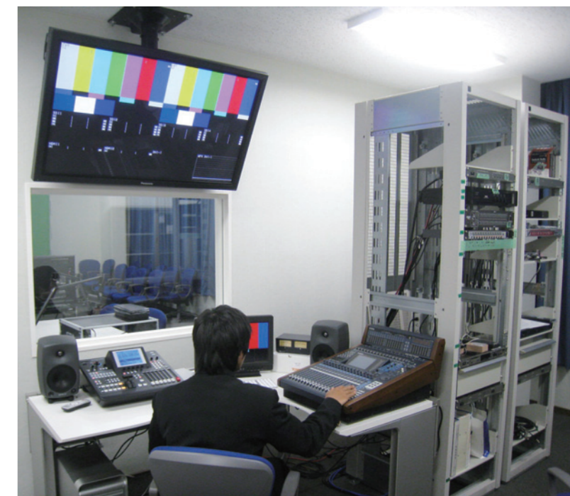
コントロール室
